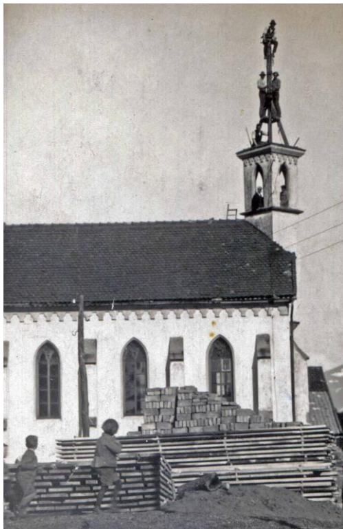
Abbruch des Turmes (Chronik Fritzens)
