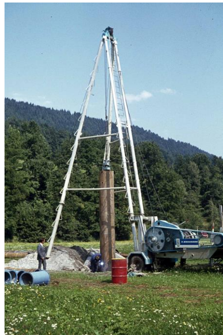
Bohrung für den Tiefbrunnen (Chronik Fritzens)
