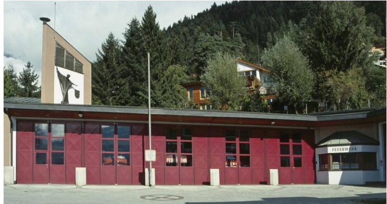
Das neue Feuerwehrgerätehaus (Chronik Fritzens)
