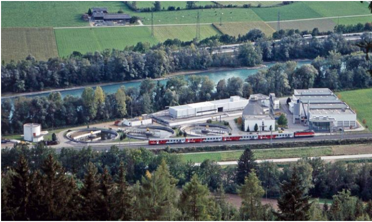
Die regionale Kläranlage (Chronik Fritzens)
